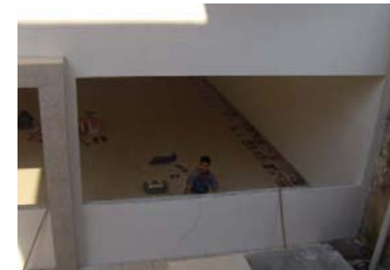
Obras do auditório em fase final
